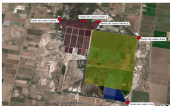
Figura 2. Planta de Tratamiento Paramillos. Fuente: Observatorio del Agua de Mendoza.
